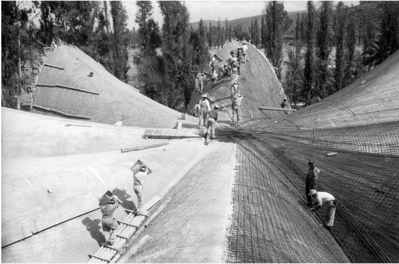
Juan Guzmán Construction of Los Manantiales Xochimilco, Mexico City (1958) © Colección y Archivo de Fundación Televisa/Fondo Juan Guzmán
